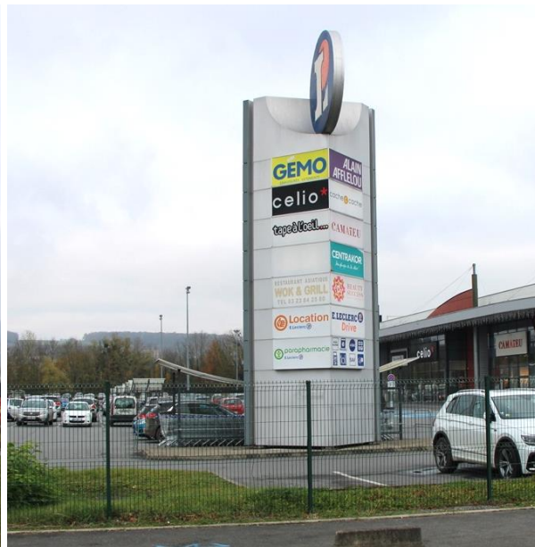
Illégale (surface > à 12 m 2 )
