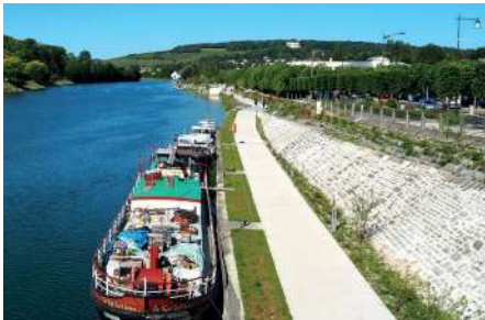
L'avenue Jules Lefebvre en surplomb du récent aménagement de la promenade de coeur de ville, qui s'ouvre sur la Marne
