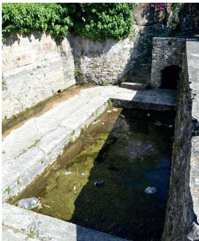
Ancien lavoir, les Chesneaux
