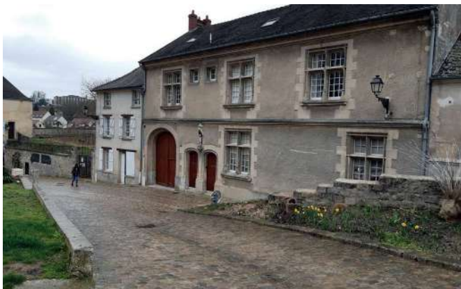
33bis rue du château
