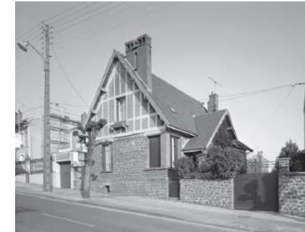
69 avenue de Soissons
