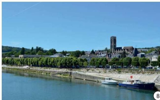
Depuis le pont, rue Carnot
