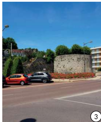
Les remparts depuis l'avenue Jousaume Latour
