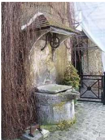
Puits rue Jean de la Fontaine
