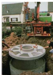
Installation d'une citerne enterrée
