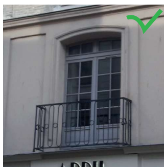
Exemple de remplacement de menuiserie en bois peint
