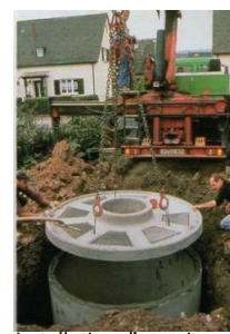
Installation d'une citerne enterrée
