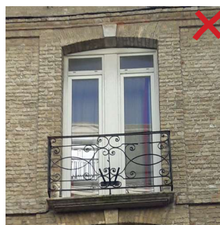
Exemple de remplacement de menuiserie ne respectant pas le dessin initial
