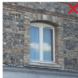
Exemple de remplacement de menuiserie ne respectant pas le dessin initial
