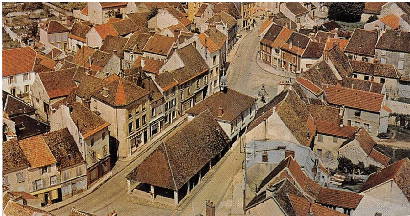
Vue aérienne de la place des Halles (2 e tiers du XX e siècle)
