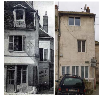
Enduit ciment en rupture avec les enduits traditionnels
