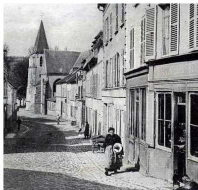
Traitement routier de la Grande Rue
