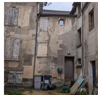
Enduit ciment en rupture avec les enduits traditionnels
