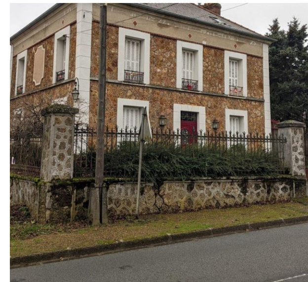
Mur bahut surmonté d'une grille rue du Cahot
