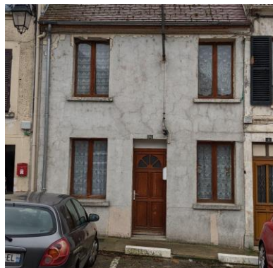
Enduit ciment en rupture avec les enduits traditionnels
